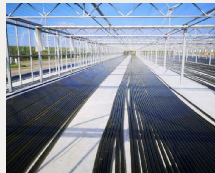
Bij de demofabriek van Photanol in Delfzijl worden blauwalgen ingezet om melkzuur voor bioplastics te maken. Het gaat om een duurzaam proces waarvoor Solution Partner SieTec uit Terneuzen de automatisering verzorgde met technologie van Siemens.
