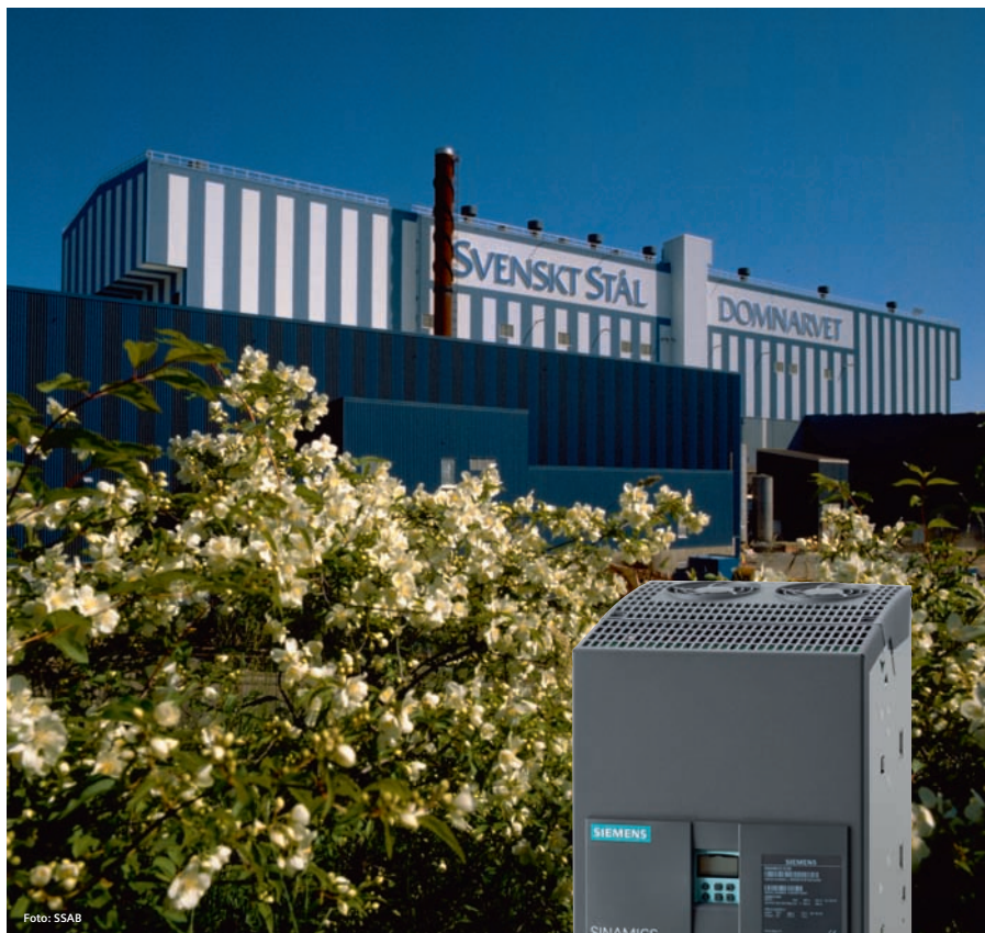
Kontinuerliga glödningslinjen utifrån. Linjen kommer att utrustas med nya automations- och drivsystem från Siemens.
