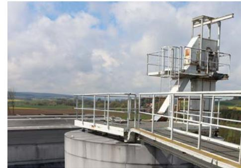
Der Radar-Messumformer Sitrans LR560 kann den Füllstand des Scherbensilos kontinuierlich über die gesamte Silohöhe zuverlässig ermitteln.
