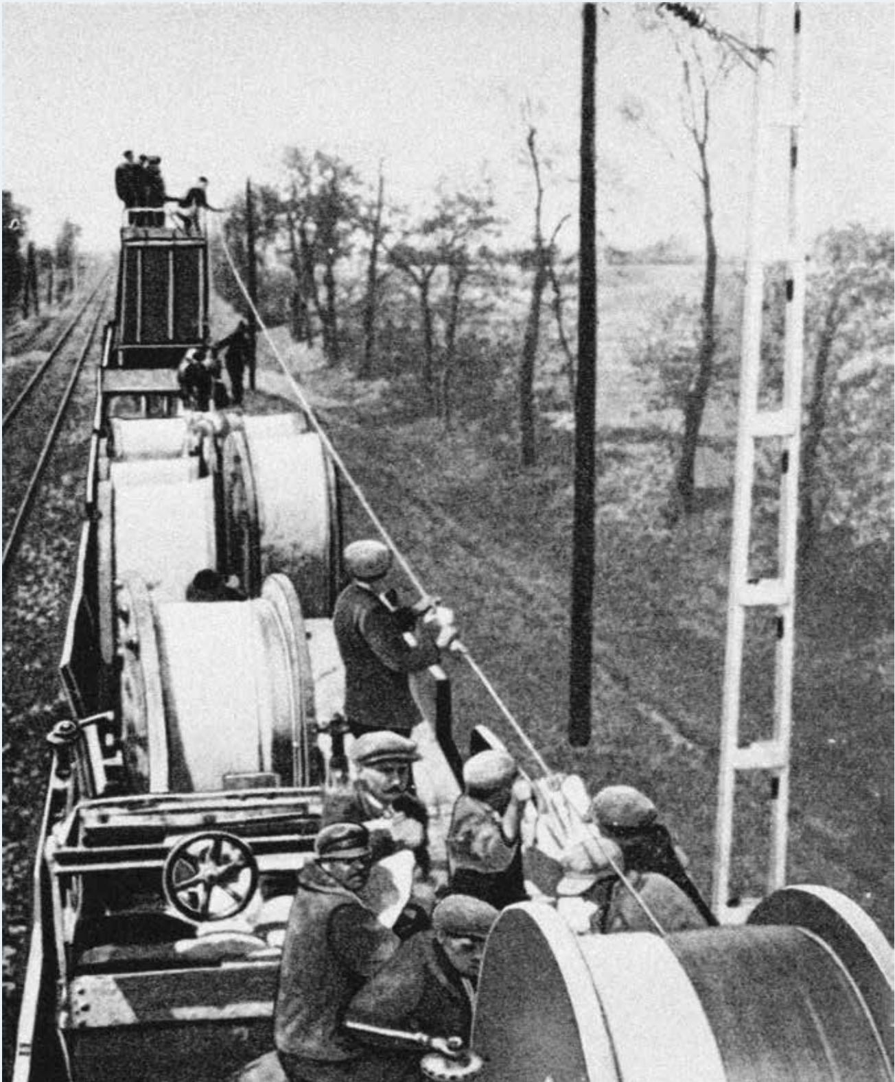
Munkavezeték feszítés a Budapest és Hegyeshalom közötti vasútvonal villamosításán, 1931. A felsővezetékét a Siemens–Schuckert Művek Szár–Tata-Tóváros állomások között telepítette
