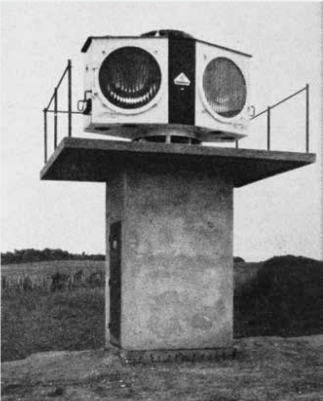
A Magyar Siemens–Schuckert Művek által szállított, forgatható térvilágító fényszóró a budaörsi repülőtéren, 1937
