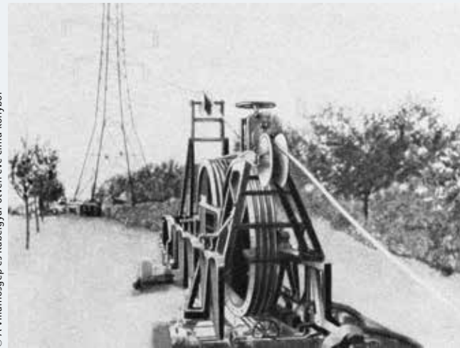
A mátrai távvezeték nagy keresztmetszetű acél- és alumíniumköteleinek feszítéséhez különleges célszerszámokra – behúzó csörlőre, kötélfeszítő szerkezetre – volt szükség
