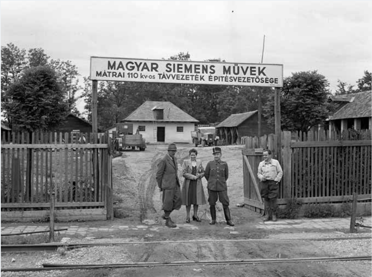
A mátrai távvezeték-építés központja Gödöllőn, 1943
