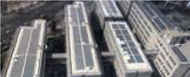
西门子园区已安装光伏设备
