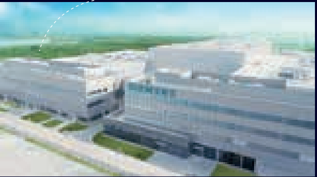
SNC俯瞰图及内部图
