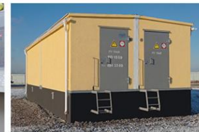
Две малогабаритные БРП 10 кВ, КВЦ «Экспофорум»
