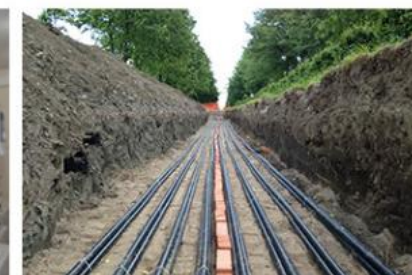
Строительство 8КЛ 10 кВ, КВЦ «Экспофорум»
