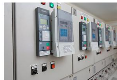
КРУЭ 8DJH - компактные не обслуживаемые распределительные устройства
