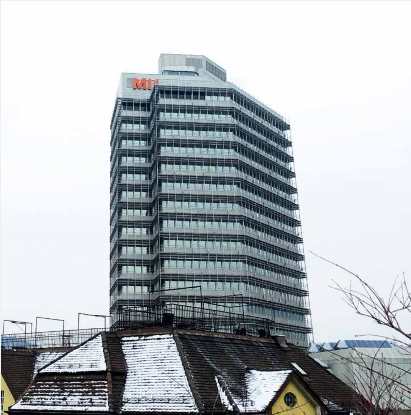
In einem Pilotprojekt wurde mit Desigo CC der 12. Stock im Migros-Verwaltungsgebäude in Zürich automatisiert. Bis Ende 2018 soll nun das gesamte Gebäude nachgerüstet werden.
