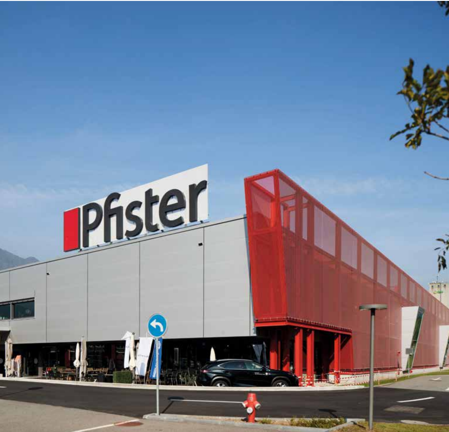
Beim Umbau der Möbel Pfister Filiale in Contone TI wurden die Brandsicherheit, Sprachalarmierung und der Einbruchschutz durch Siemens aufgewertet.
