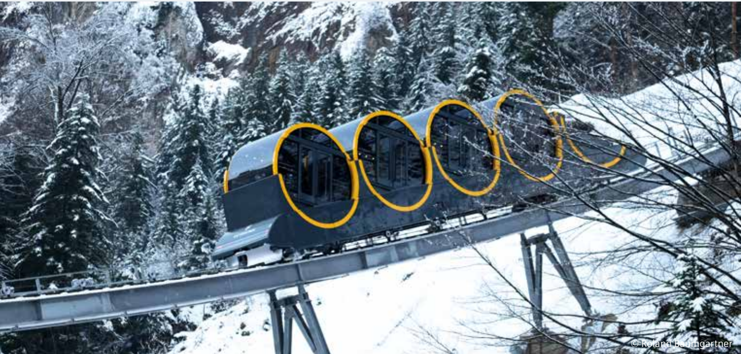
Mit der Sinteso Brandmeldeanlage von Siemens können Brände in den Gebäuden der Stoosbahn frühzeitig erkannt und gemeldet werden.
