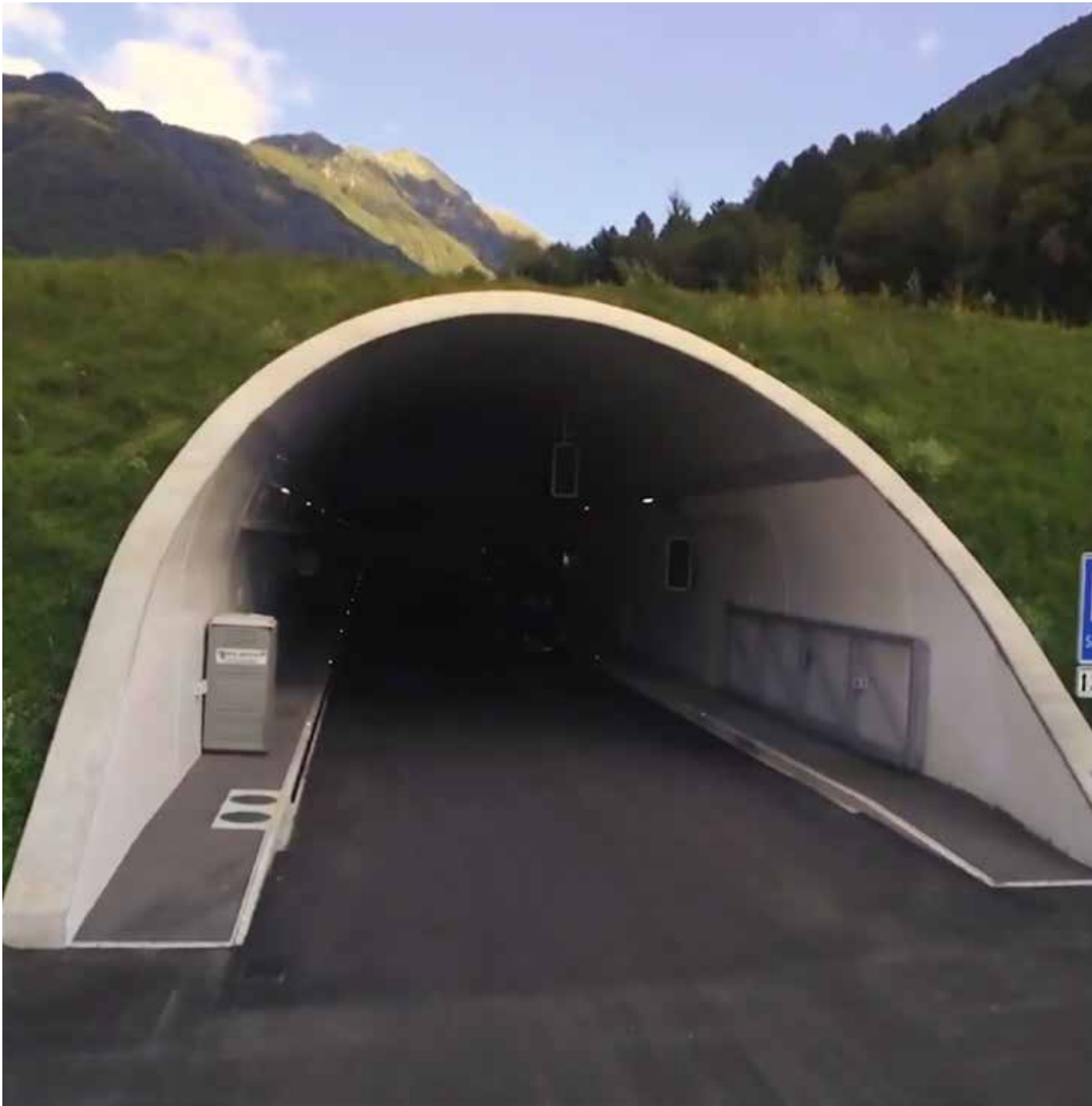
Das Überwachungssystem von Siemens im Tunnel San Fedele meldet frühzeitig Brandausbrüche.
