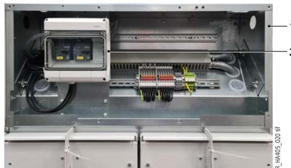
Niederspannungsnische eines Verrechnungsmessfeldes Typ M, Abdeckung geöffnet
