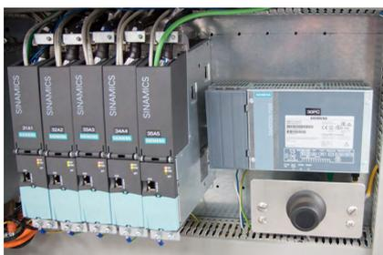
A droite des variateurs SINAMICS, le cœur du contrôle de mouvement SIMOTION P320 sur base PC. En dessous, SACMO a ajouté un module radio permettant de piloter la machine avec une tablette.
