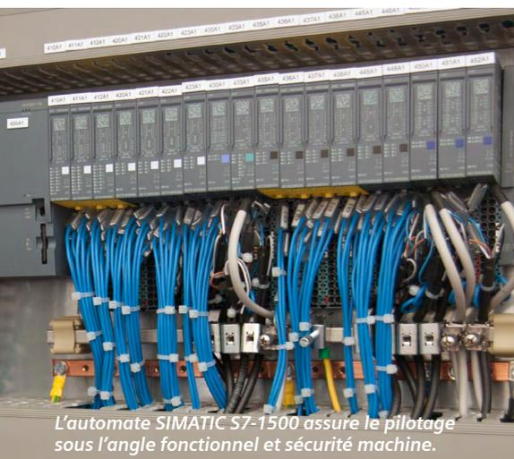
L'automate SIMATIC S7-1500 assure le pilotage sous l'angle fonctionnel et sécurité machine.
