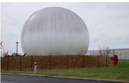
Ce réservoir de biogaz à l'état gazeux de 1 900 m<sup>3</sup> ne pourrait occuper que 3 m<sup>3</sup> pour une même quantité de gaz à l'état liquide, d'où l'un des enjeux de la liquéfaction du biogaz par le procédé Cryo Pur.
