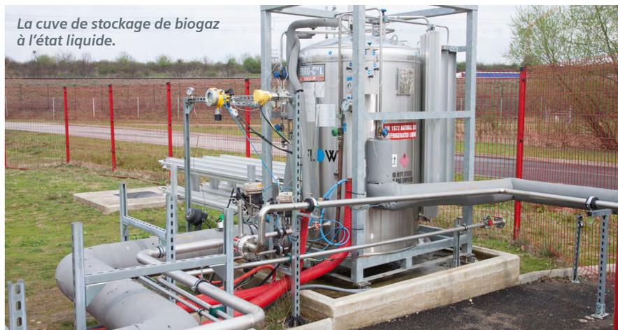
La cuve de stockage de biogaz à l'état liquide.
