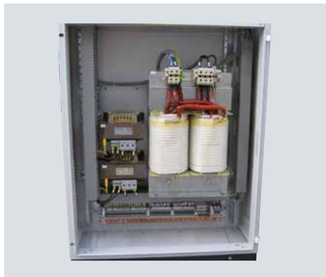
Trasformatore di isolamento
