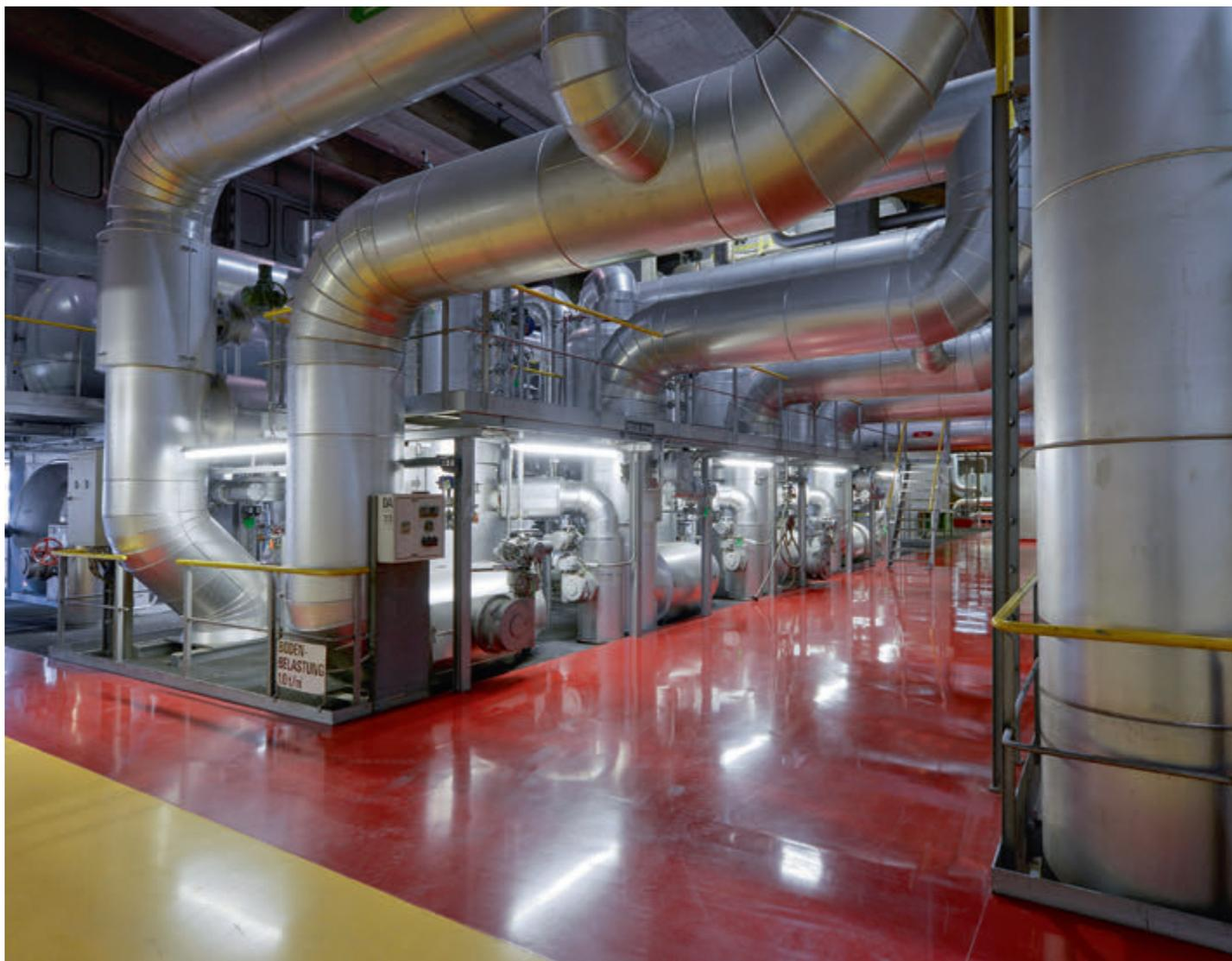
In der Anlage Aubrugg wird mit zwei fossil befeuerten Heizkesseln die Spitzenlastenergie für das Fernwärmenetz der Stadt Zürich erzeugt.
