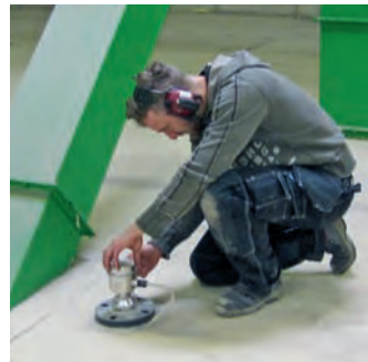
Elektrikern Andreas Lidberg, Kalmar Lantmän, kopplar in en radarnivåmätare, Sitrans LR560, i toppen på en av de 25 höga silorna.
