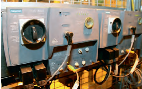
På linjen sitter ett trettiotal motorstartare Sirius M200D som manövreras via AS-Interface.
