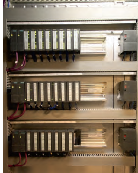
Redundant Simatic ET 200M-system i ställverksrummet med distribuerade I/O via Profibus.
