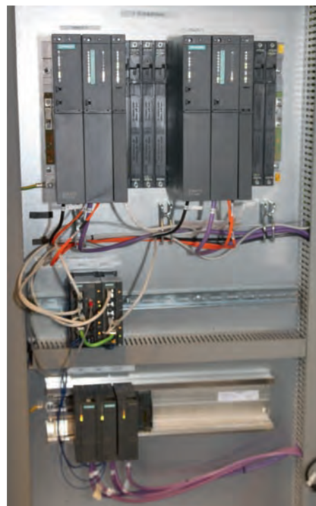
Redundant Simatic ET 200M-system i ställverksrummet med distribuerade I/O via Profibus.
