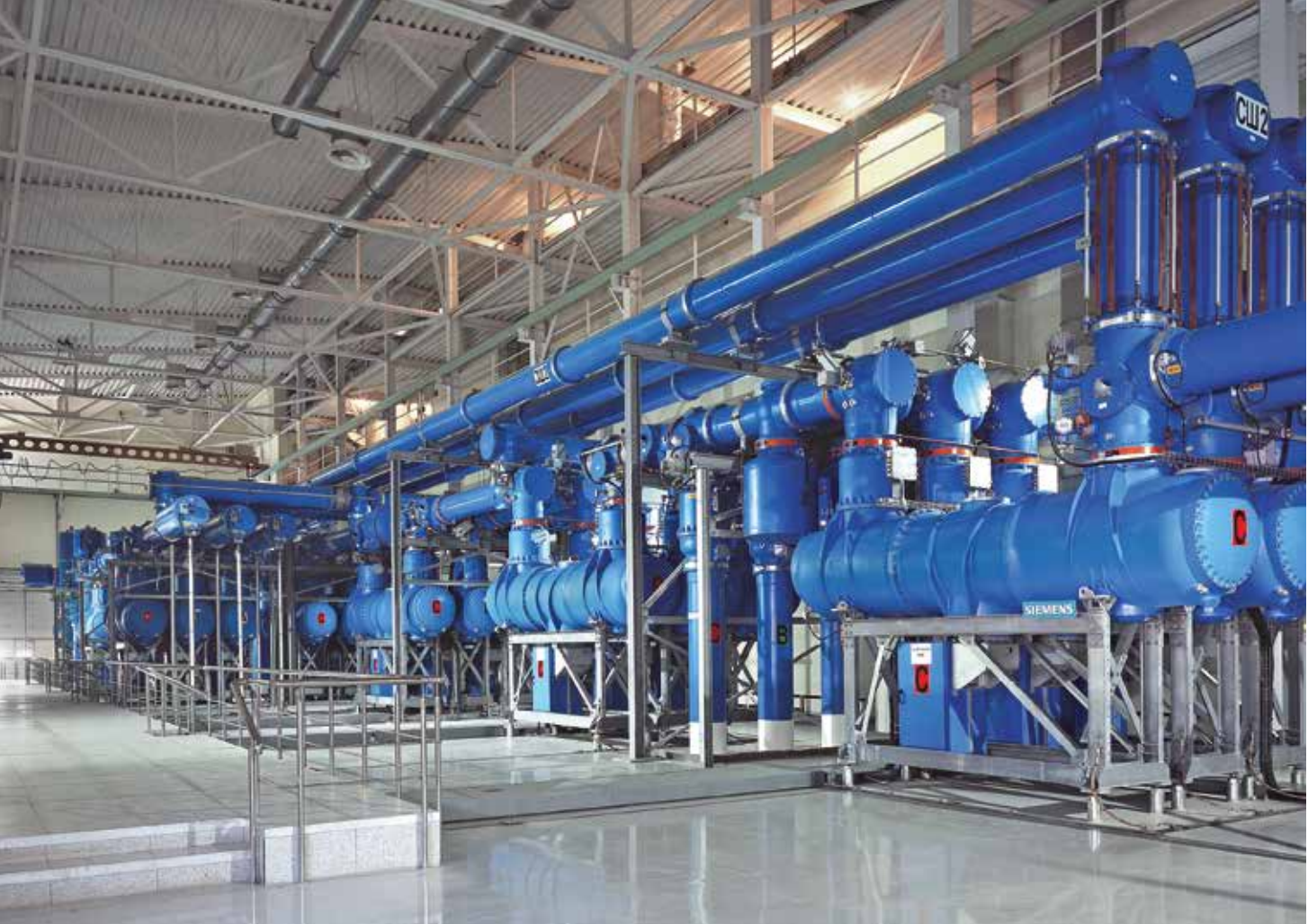
Die Siemens-8DQ1-Schaltanlage für bis zu 550 kV steht für überlegene Leistung bei anspruchsvollen Aufgaben in der Energieübertragung.
