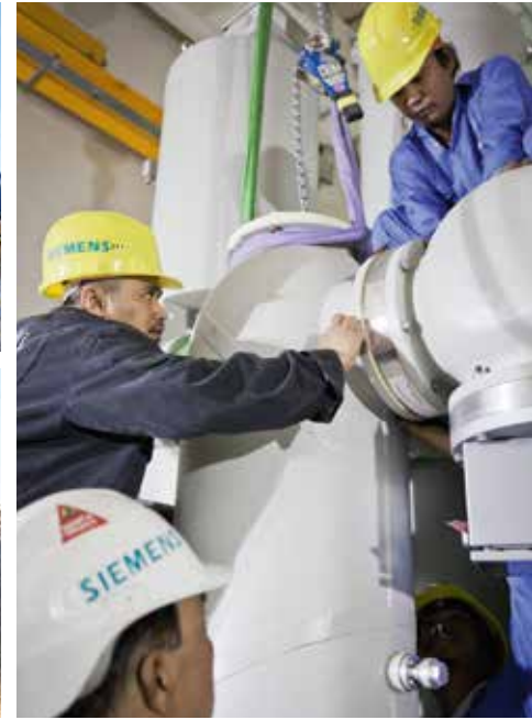
Montage vormontierter Transporteinheiten vor Ort.
