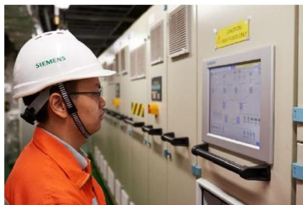
在动力包系统中，变压器将发电机产生的电力转化至可供驱动系统和日常生活使用的电压。NXPlus C 中压配电板和 SIVACON 8PT 低压配电板则有效地把电力分配和传输到各个关键设备。此外，8 台 GM150 推进变频器和 8 台 H-compact PLUS 推进电机则完美协同，源源不断地为 360 度全回转推进器提供动力。BlueDrive 钻井变频器则对钻井电机的转速转矩进行灵活调节。
