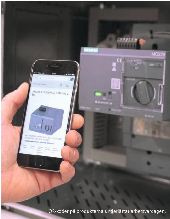
Anders Lidström, verkstadschef på Sundsvalls Elteam, Jonas Andersson, tekniskt säljstöd på Sundsvalls Elteam, Leif Åsberg, grundare och delägare av Sundsvalls Elteam, och Christoffer Höglund, kundansvarig säljare på Siemens, framför ställverken som har levererats till Vattenfalls Sättra kraftstation.
