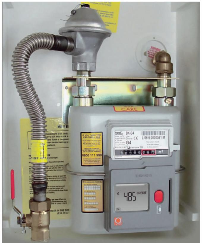
Рис. 10.3-3: Счетчик предоплаты Q-Smart установлен
