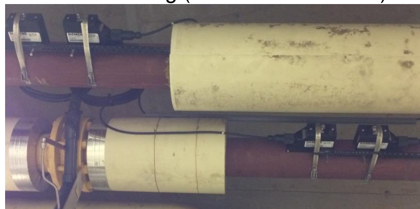
Không hàn cắt đường ống
