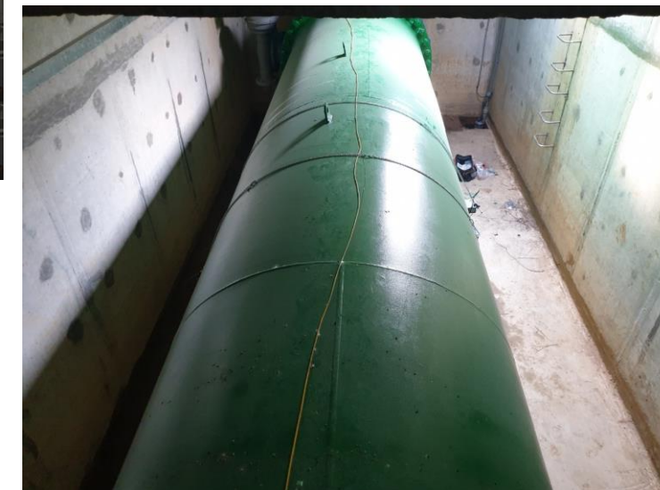
Đường ống lớn 1.8m
