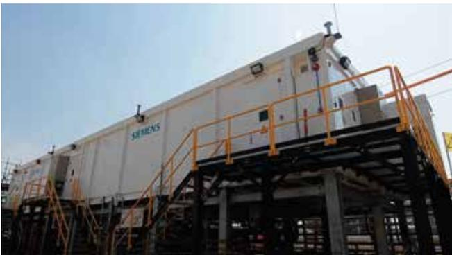
Siemens hat ein kolumbianisches Unternehmen, das leichtes Rohöl, Schweröl und Zwischenmischungen transportiert, erfolgreich mit individuell angepassten, voll ausgestatteten und vorab geprüften modularen E-Houses beliefert. Die E-Houses sichern die schnelle und zuverlässige Stromversorgung auf Ölplattformen und enthalten das umfassende Portfolio an Mittelspannungs- und Niederspannungsschaltanlagen sowie Schienenverteilersystemen.
