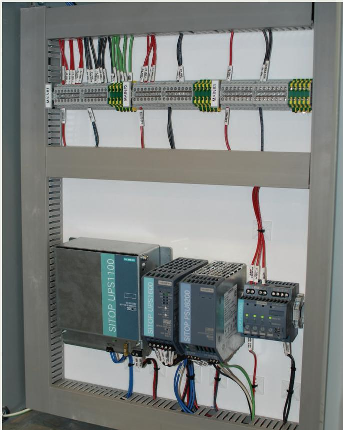
24-V-DC-USV SITOP UPS1600, die bei EPWater mit dem Batteriemodul UPS1100, der SITOP-Stromversorgung PSU8200 und der zusätzlichen Schutzschaltung PSE200U installiert ist
