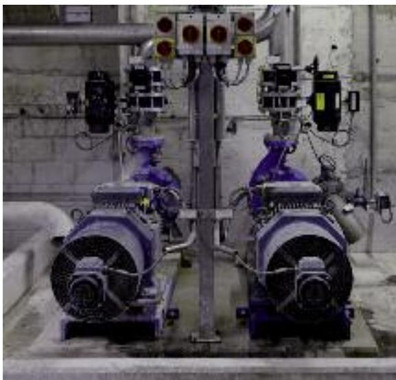
In der Pumpstation fördern zwei Zentrifugalpumpen das mit Feststoffen belastete Abwasser.
