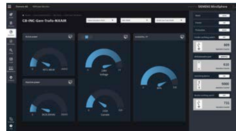
Betriebsübersicht verbundener Schaltanlagenfelder
