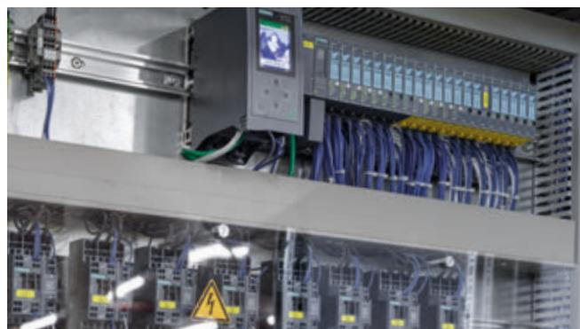
Chaque transstockeur est commandé par sa propre Simatic S7-1500F. Les automates s'accordent parfaitement avec le système de gestion de stock d'Emil Frey.
