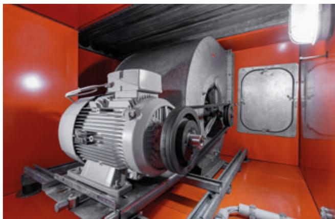
Le moteur à reluctance Simotics avec une puissance de 11 kW dans la zone de l'air entrant du ventilateur monobloc possède une efficacité énergétique très élevée avant tout dans le domaine de la charge partielle.
