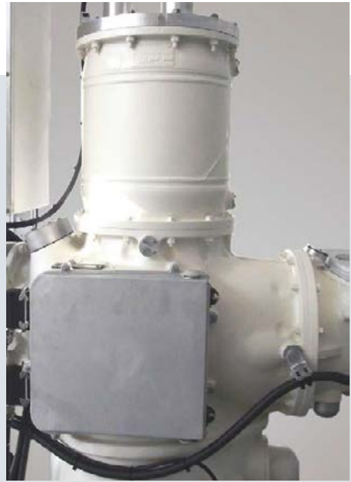
Fig. 56: 145 kV RC divider for GIS
