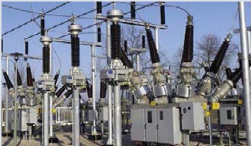
Fig. 17: 3AP1 DTC 145 kV
