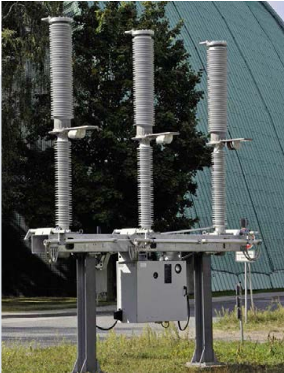
Fig. 21: 3AP1 DCB 145 kV
