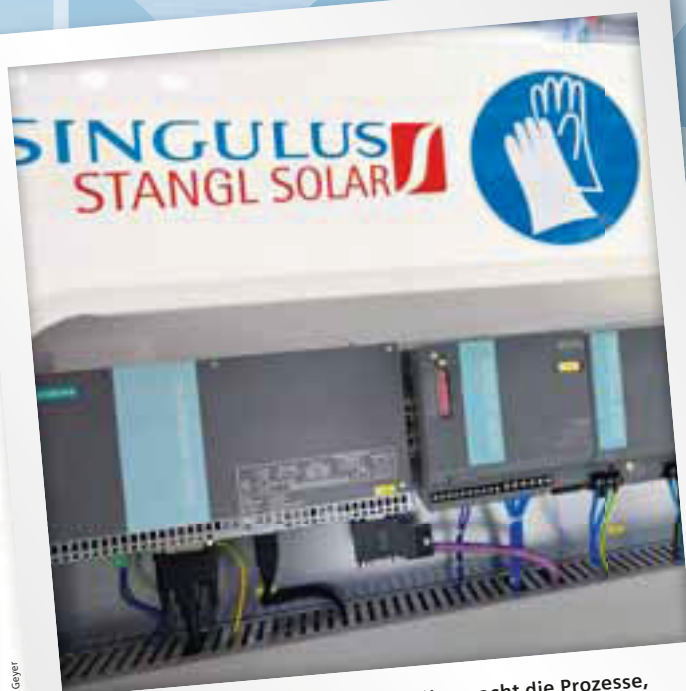
Ein Simatic Microbox PC steuert und überwacht die Prozesse, Sitop Netzteile sorgen für die zuverlässige Spannungsversorgung
