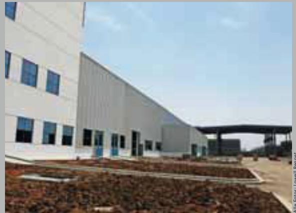
Das neue HBI Firmengebäude in Nanjing
