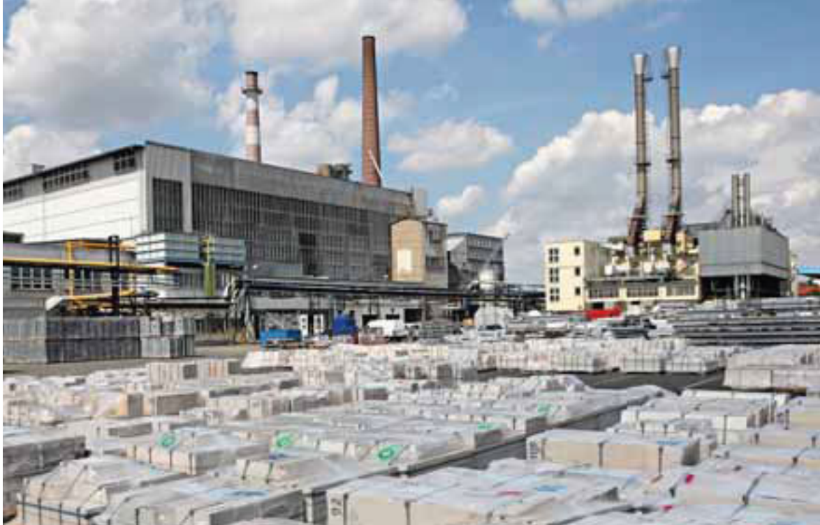
Für die Vetropack Moravia plante HORN Glass Industries die gesamte Glasanlage mit einer Schmelzleistung von 350 t/d
