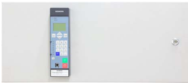
Рисунок 37: Низковольтный отсек с прибором управления и защиты серии SIPROTEC 4
