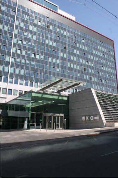
Wirtshauskammer Österreich (WKO) | Office Building
