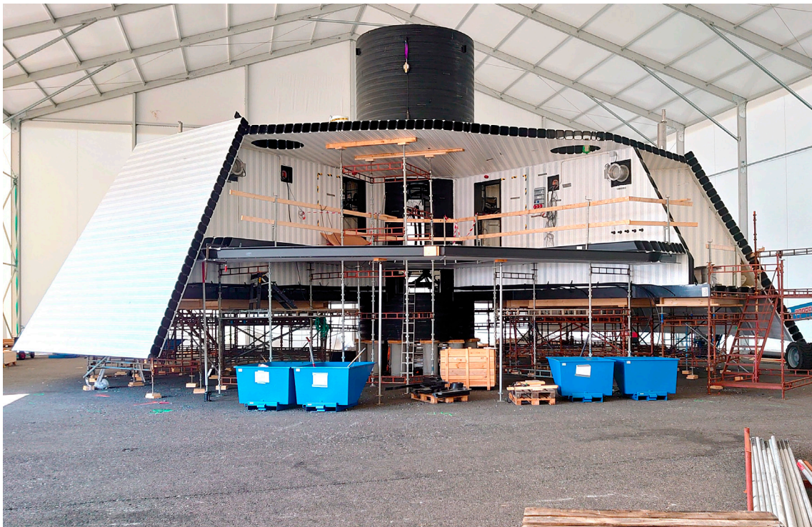
3,5K under konstruksjon. Paneler og firkantrør i lagvis PE-profil. Dette gir en dobbelbarriere mot omgivelsene og en mer bestandig merd. Termoplast gir dessuten redusert vedlikehold.
