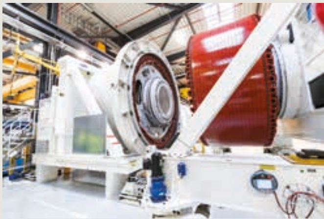
I "marriage-processen" føjes et 15 tons "rotorhouse", en 20 tons "stator" samt en række andre komponenter sammen til en 84 tons generator – i en fuldautomatisk proces.
