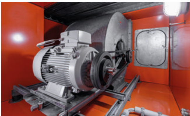
Der Simotics Reluktanzmotor mit einer Leistung von 11 kW im Zuluftbereich des Lüftungs-Monoblocks ist vor allem im Teillastbereich äusserst energieeffizient.
