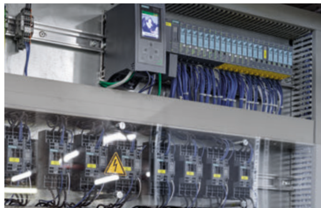
Jedes der fünf Regalbediengeräte wird von einer eigenen Simatic S7-1500F gesteuert. Die Steuerungen spielen perfekt mit dem Lagerverwaltungssystem von Emil Frey zusammen.
