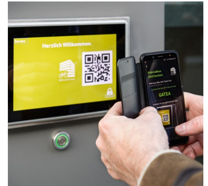
La Siemens Simatic S7-1500 et un routeur DSL assurent avec l'appli la communication cryptée entre le Cloud et le système de commande.
