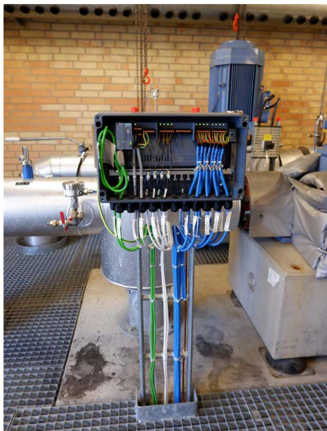
CFU'en set forfra med/uden dæksel. PA-instrumenterne tilkoblet til højre, digitale signaler i midten og PROFINET-forbindelsen længst til venstre.
