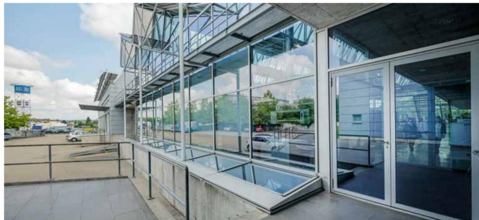
Les anciens modules à double vitrage de la façade latérale sont remplacés au fur et à mesure par des modules à triple vitrage.
