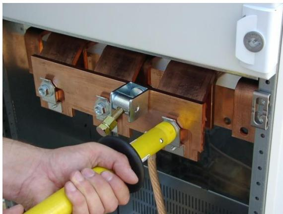
Figura 12: Apertar manualmente as porcas do condutor exterior com barra de isolamento
