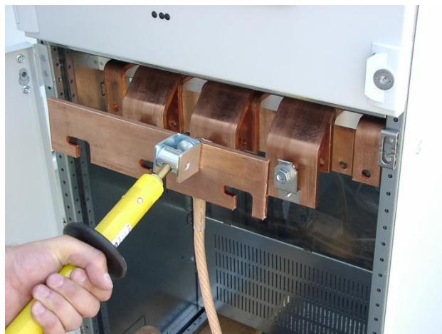
Fig. 9: Definir o ângulo mais adequado ao manuseamento da barra com a barra isolante
