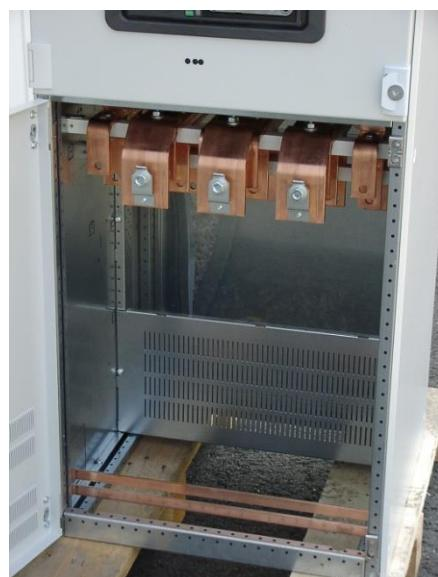
Fig. 6: Todas as porcas desparafusadas antes de colocar a barra de curto-circuito
