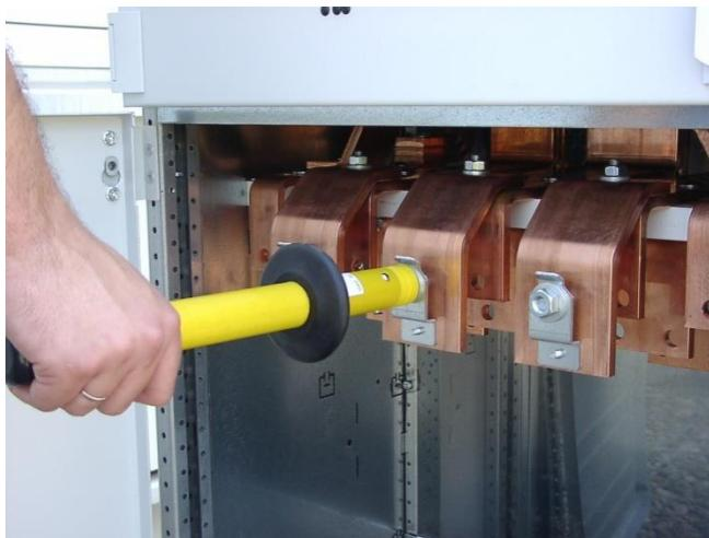
Fig. 5: Porca L1 desparafusada, desparafusar porca L2
