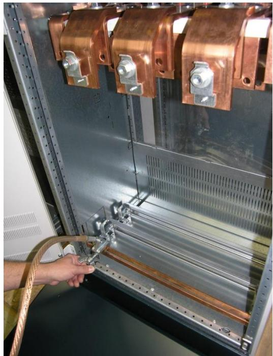
Fig. 7: Conectar o grampo de terra em PE(N).
