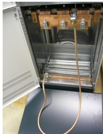
Fig. 13: Todas as porcas apertadas com barra isolante
