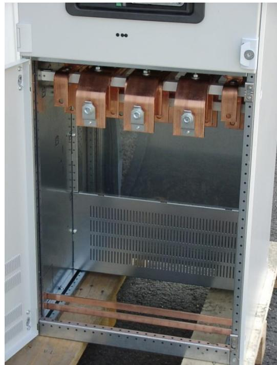
Fig. 4: Cabo de baixo, compartimento de cabos aberto
