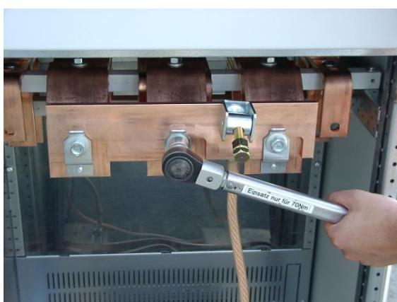
Fig. 14: Apertar as porcas do condutor exterior com chave dinamométrica com 70Nm
