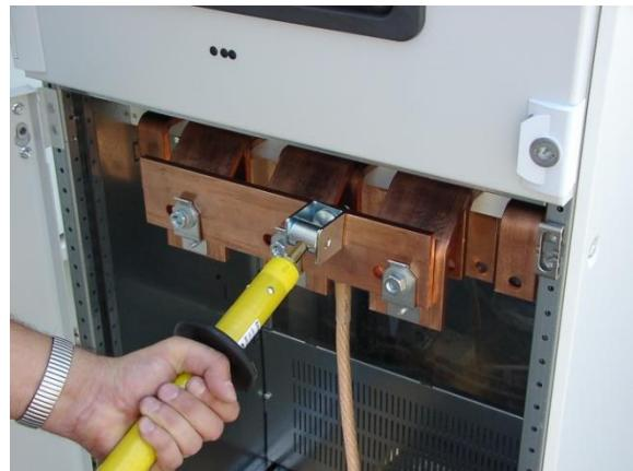
Figura 11: Deslocar a calha para baixo até ao batente e depois lateralmente (apenas no caso do interruptor BG2 ou 3).
