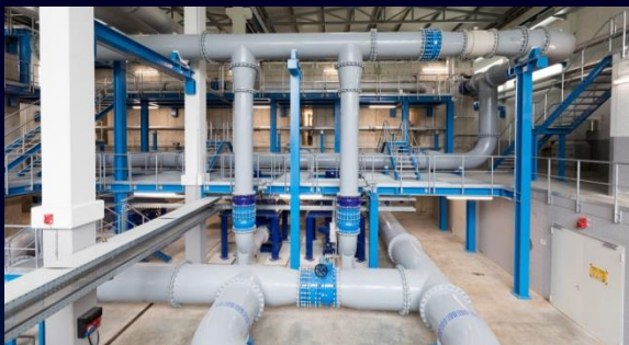
Sistemas SCADA de supervisión y control
