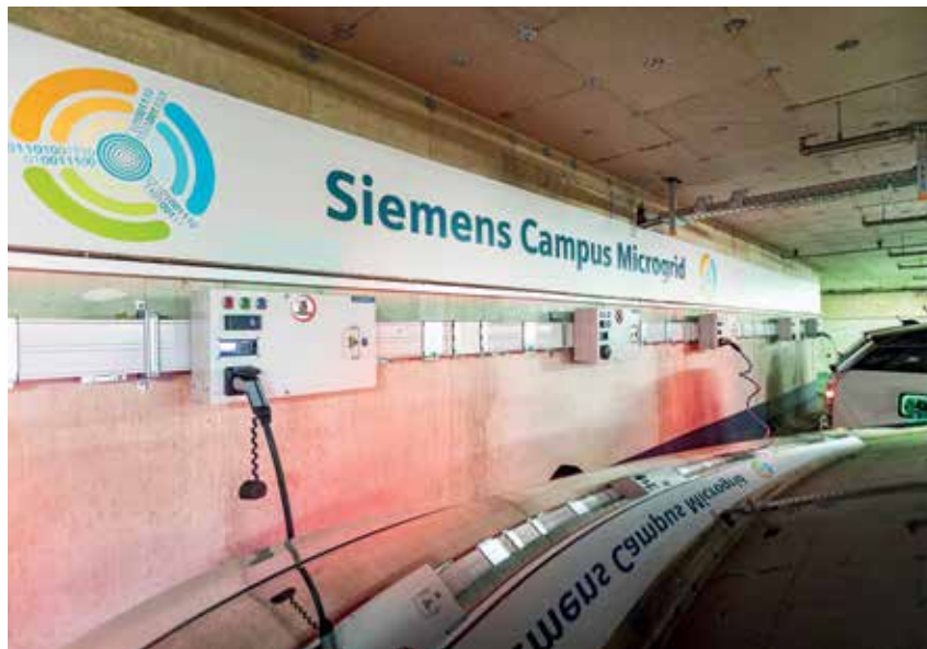
Зарядните станции в централата на Siemens във Виена са тестова среда за разработването на система, която ще оптимизира експлоатацията на микромрежата
