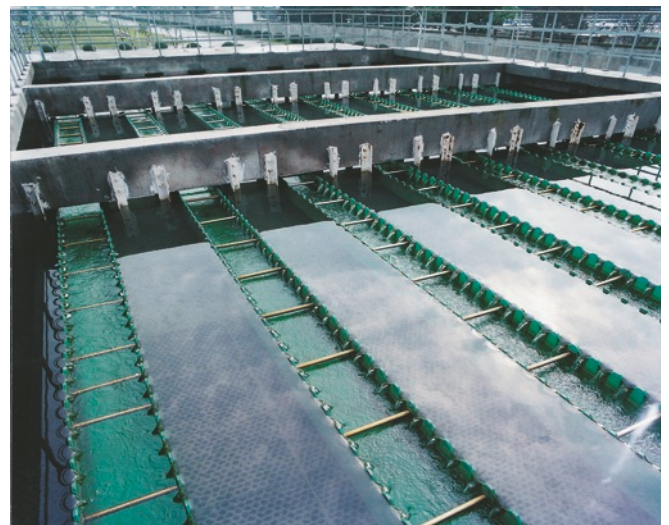
Mit LTE können auch abgelegene Brunnen in ländlichen Gegenden, Silos oder Kläranlagen kontinuierlich überwacht werden
