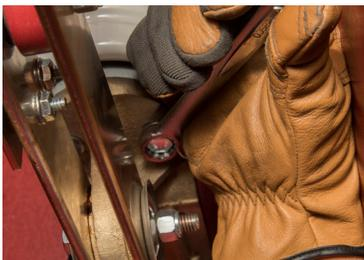
Figure 43 : Desserrez les boulons de montage de la charnière
