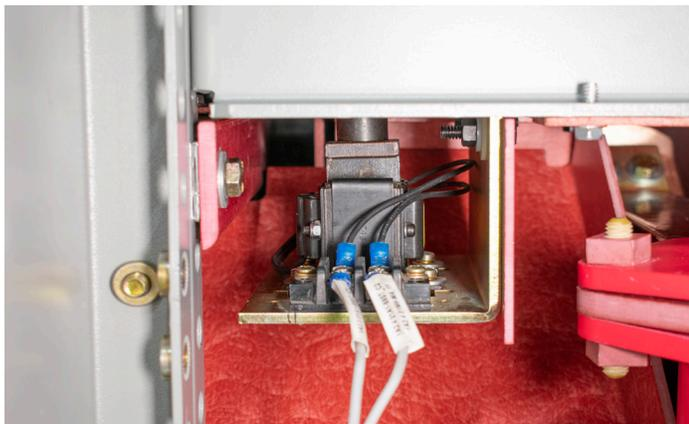
Mécanisme de déclencheur de dérivation
