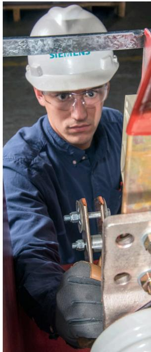
Figure 44 : Reconnectez les tiges de poussée
