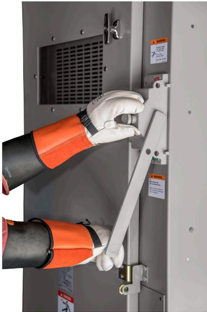
Figure 29 : Fonctionnement de l'interrupteur de charge
