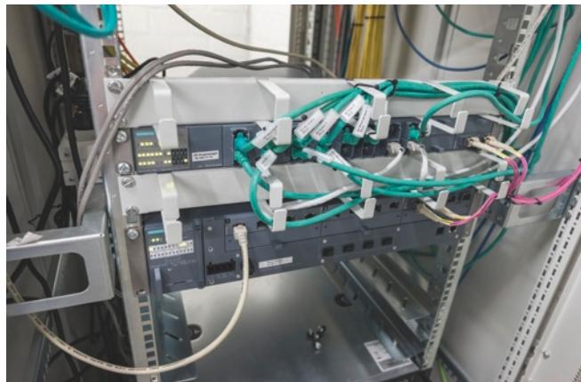
Die Switches SCALANCE X sind verteilt in dezentralen Schaltschränken eingebaut.
