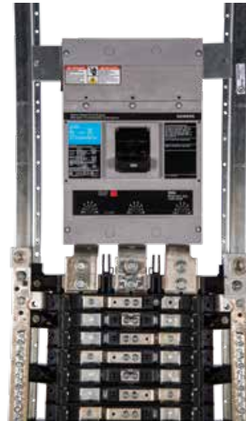
Disjoncteur principal de 300 A installé. Ces ensembles P1 de nouvelle génération peuvent maintenant être utilisés pour l'alimentation par le dessus ou le dessous.
