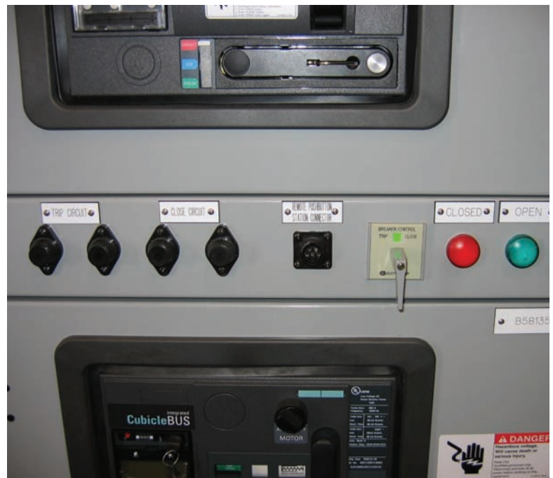
Port de contrôle sur appareillage de connexion WL
