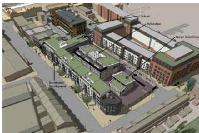
Schematische Darstellung des Projektes: In der Mitte des Bildes das Gebäude des Umspannwerkes, in das die Transformatoren eingebaut werden. Am linken oberen Bildrand die durch das Wärmerückgewinnungssystem mit Abwärme zu versorgende Schule
