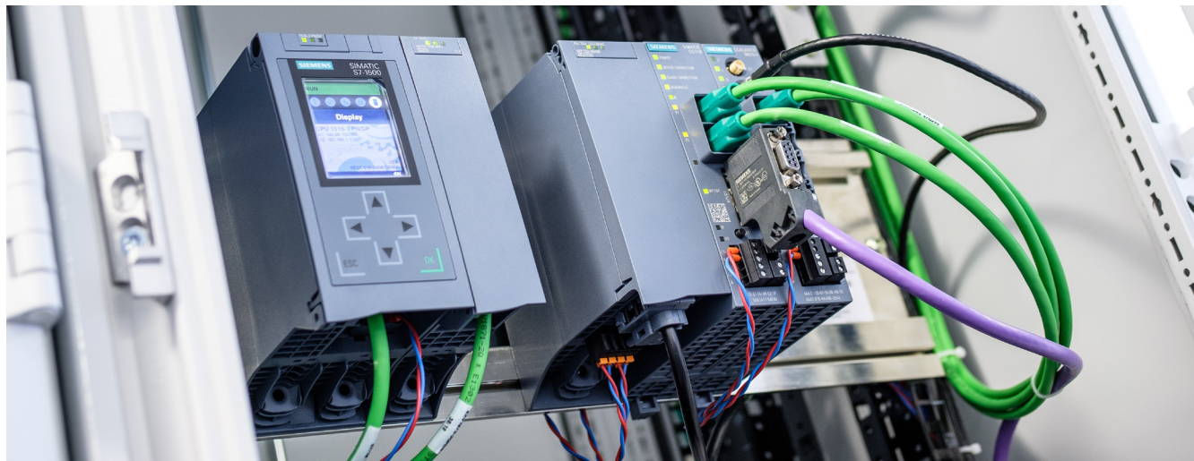
Das Bild zeigt von links nach rechts die komplette Kommunikationskette: Steuerung SIMATIC S7-1500, cloudfähiger Kommunikationsprozessor SIMATIC CP1545-1, geregelte Stromversorgung SIMATIC PM 1507, cloudfähiges IIoT-Gateway SIMATIC CC716, LTE- bzw. 4G-Mobilfunkrouter SCALANCE M876-4.
