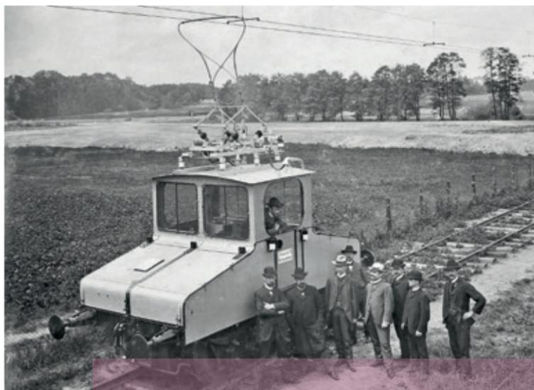
Siemens-Versuchsbahn in Lichterfelde – Walter Reichel (2. v. l.) testet gemeinsam mit Emmerich Frischmuth (4. v. l.) und Kollegen Drehstromtechnik, Bügelstromabnehmer und Fahrleitungen.
