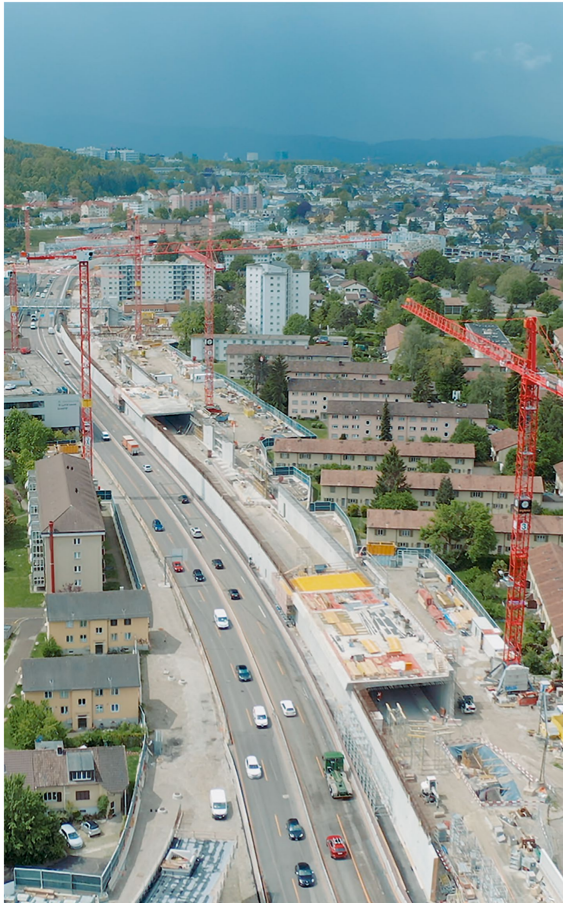
Vue d'ensemble du méga chantier de la tranchée couverte de Schwamendingen.
