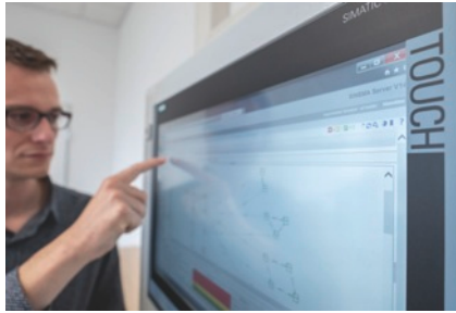
SINEMA Server unterstützt die Mitarbeiter der Anlagentechnik beim Netzwerkmanagement und erleichtert die Diagnose und Behebung von Störungen erheblich.
