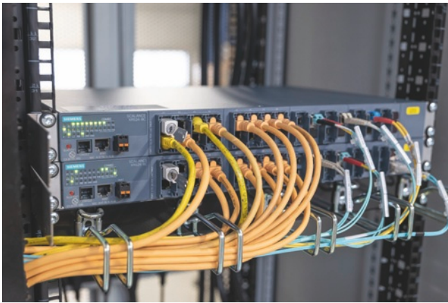
Herzstück des neuen Produktionsnetzwerkes: zwei der insgesamt 32 Switches vom Typ SCALANCE XR524, die die Kommunikation über einen redundanten Industrial Ethernet-Ring mit bis zu 1 Gigabit ermöglichen.
