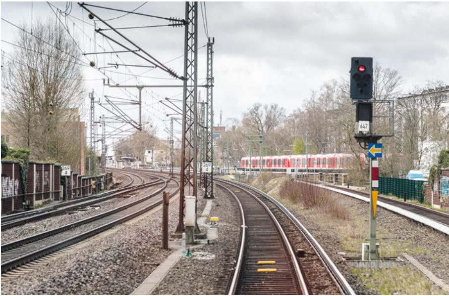
Abb. 3: Streckenausrüstung S-Bahn-Strecke mit Ne 14 und Balisen
