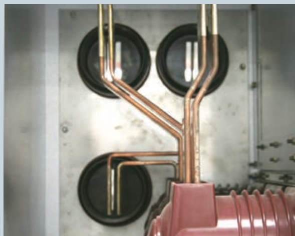
额定短路开断电流25kA/31.5kA，额定电流2500A母线室结构
