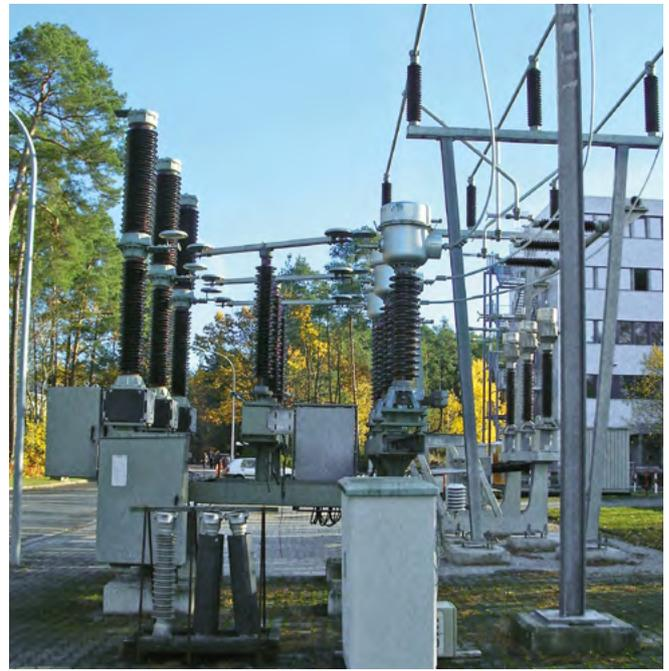
Fig. 3.1-23: SIMOBREAKER module
