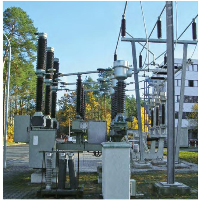
Fig. 3.1-23: SIMOBREAKER module
