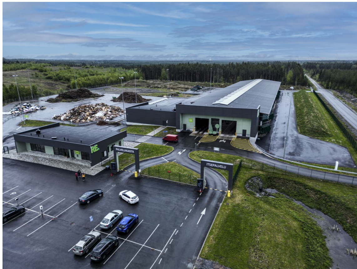
RE-piste lämpenee maalämmöllä, ja Tuubin katolle tuleva sadevesi kerätään talteen ja puhdistetaan käyttövedeksi vessoihin, suihkuun ja astianpesukoneeseen. Kierrätysasemalle on tulossa myös aurinkopaneelit.
