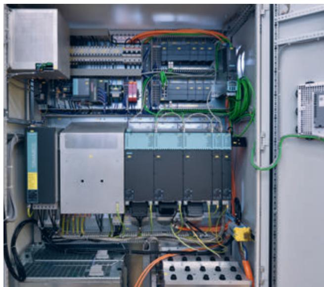
Die Energiesteuerungs- und Konversionseinheit mit der Sinamics S120 und Simotics 1PH8.
