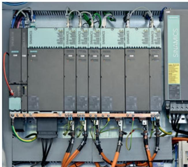
Detail des Schaltschranks, erkennbar von links nach rechts die Sinumerik 840D, auf der die digitale Steuerung aufliegt, die Versorgung des Gleichstromzwischenkreises, die eingestellten Achsmodule sowie Frequenzumrichter und eine Filterkomponente zwecks Rückgewinnung der Bremsenergien.
