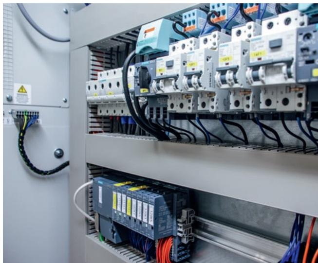
Die Simotion D435 und eine S7-1512 CPU sorgen im optimalen Zusammenspiel mit anderen Siemens-Komponenten dafür, dass die Stanzmaschine schnell und sicher produziert.
