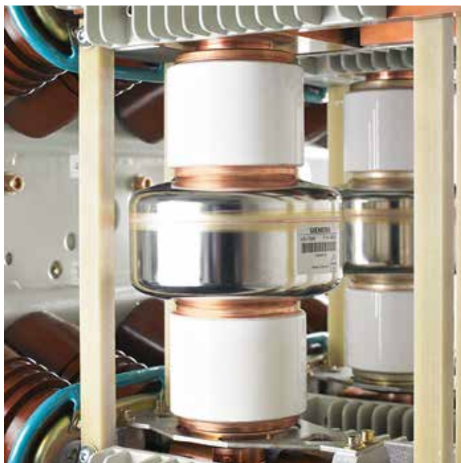
Вакуумная дугогасительная камера
